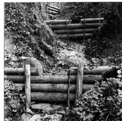
Die Sperren beim Schwimmbad (links) und Förster Thomas Wenk vor dem Biotop im Oberfeld (im Hintergrund die Bachverbauung).
