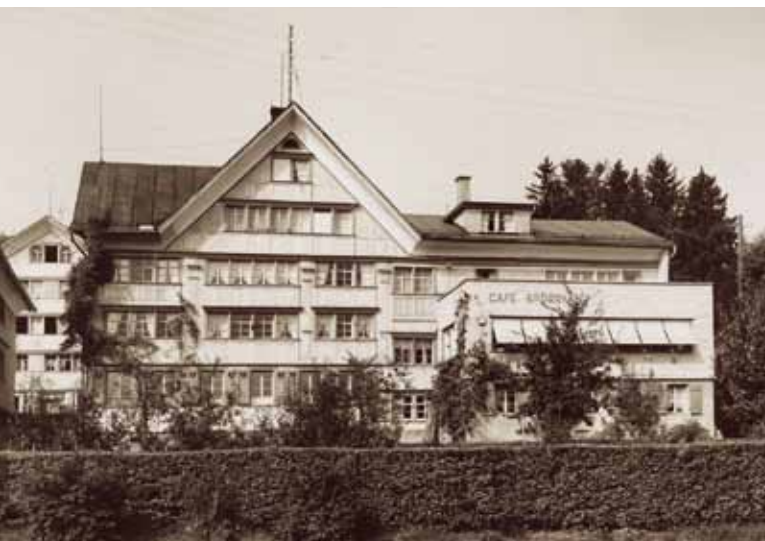
Das Café Spörri nach dem Umbau von 1932.
