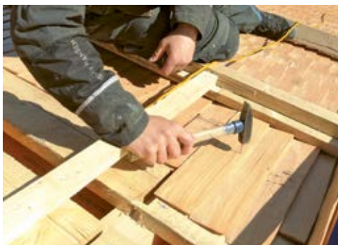
9 Angeschlagen werden die Schindeln von Hand – mit Gefühl. So haben sie später genug Spiel.
