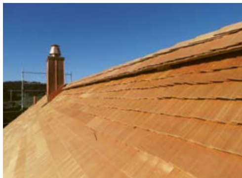
10 Ein Blick über das Dach. Gut zu sehen: Der aufgesetzte First.
